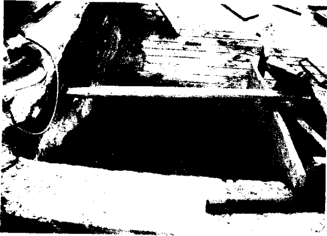
CONSTRUCCION DE RAMPA DE ESCALERA Y ENCOFRADO DE GRADERIAS.
