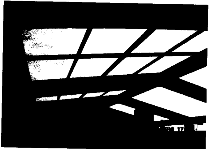
COLOCACION DE SOPORTE METALICO PARA COBERTURA DE FIBROCEMENTO SALA TAREAS PREVIAS.
