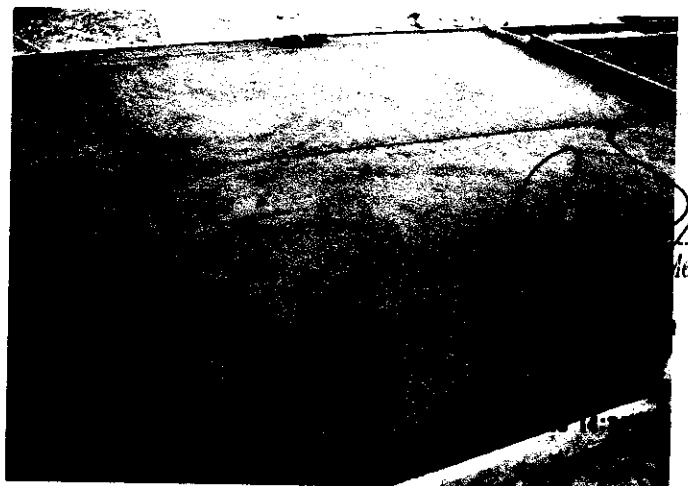
HUMEDECIMIENTO DE LA RASANTE ANTES DEL VACIADO DE CONCRETO Y ACABADO DE PISO PULIDO CON BRUÑAS DE ACUERDO A LO INDICADO EN EL PLANO.
