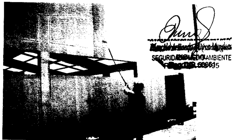
REPLANTEO DE NIVELES EN OBRA - PINTADO DE PRIMERA MANO CON PINTURA LATEX HIDRORREPELENTE COLOR BLANCO EN SALA TAREAS PREVIAS.
