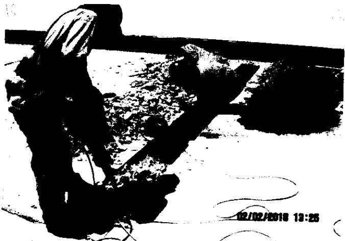
CORTE CON DISCO EN PAV. CONCRETO E=0.15-0.20m CON ROTOMARTILLO, DEMOLICION DE PISOS DE CONCRETO DE 0.20m Y EXCAVACION DE ZANJAS P/TUBERIA PARA LINEA DE EFLUENTE.
