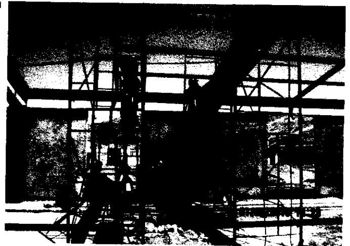
COLOCACION DE PERFILES DE 4" x4" y 3" x 3" PARA SOPORTE DE COBERTURA DE FIBROCEMENTO, SALA TAREAS PREVIAS.
