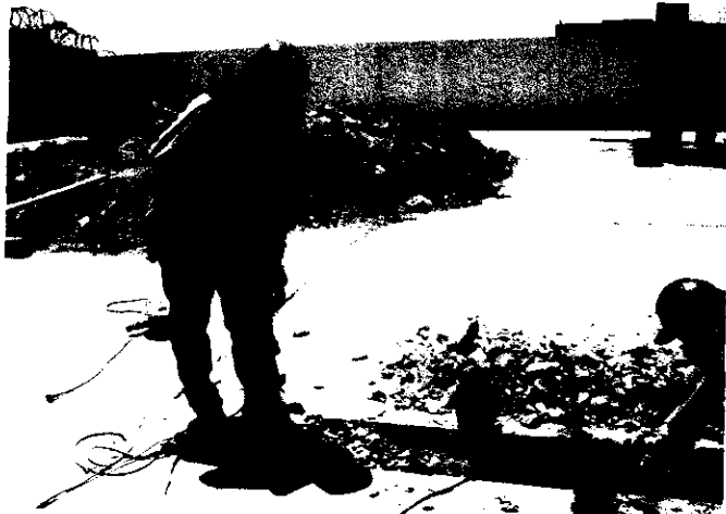
CORTE CON DISCO EN PAV. CONCRETO E=0.15-0.20m CON ROTOMARTILLO, DEMOLICION DE PISOS DE CONCRETO DE 0.20m Y EXCAVACION DE ZANJAS P/TUBERIA PARA LINEA DE EFLUENTE.
