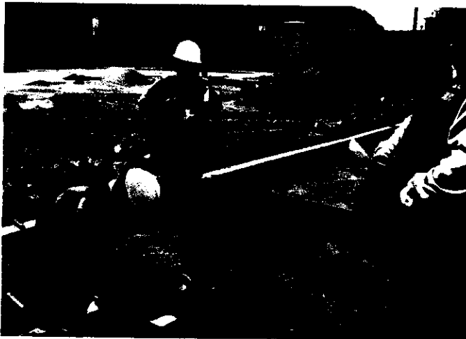
MUESTREO PARA DENSIDAD DE CAMPO POR SEGUNDA OPORTUNIDAD CON OTRO LABORATORIO DEL CUAL SE ADJUNTA LOS ENSAYOS EN ZONA DE CARGA, EN PRESENCIA DE RESIDENCIA Y SUPERVISORA DE SEGURIDAD.
