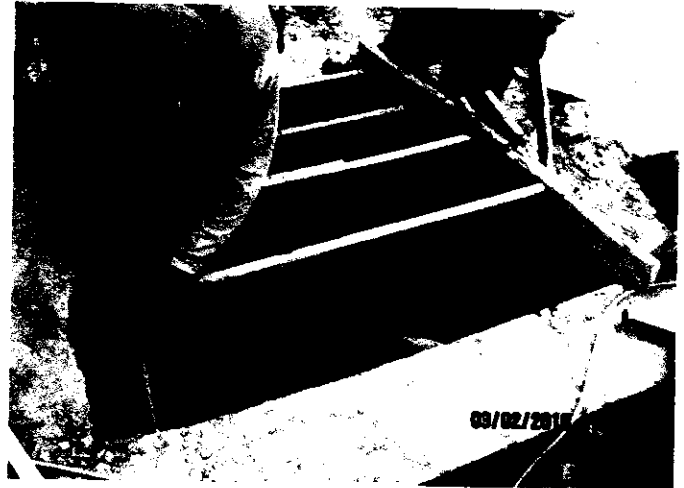
CONSTRUCCION DE RAMPA DE ESCALERA Y ENCOFRADO DE GRADERIAS.
