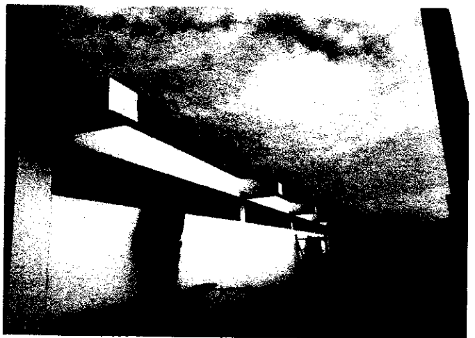
COLOCACION DE VENTANA DE ALUMINIO CON VIDRIO TRANSPARENTE DE 4 mm DE ACUERDO A LO QUE INDICA EL PLANO RESPECTIVO.
