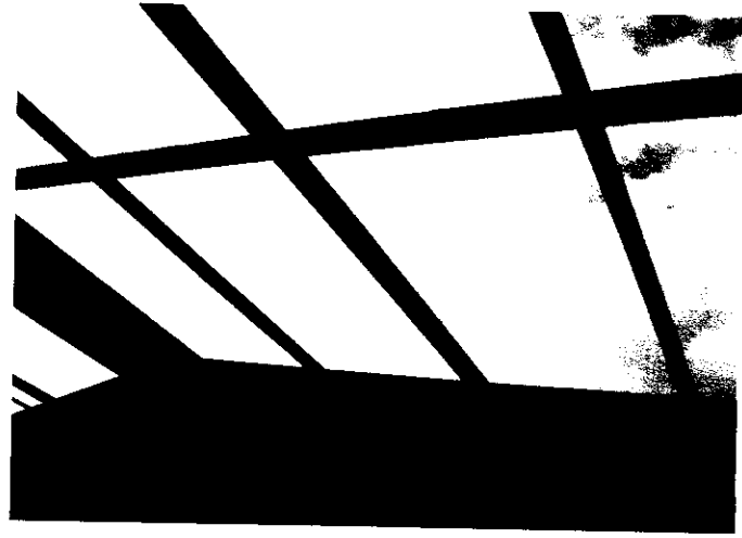
COLOCACION DE SOPORTE METALICO PARA COBERTURA DE FIBROCEMENTO SALA TAREAS PREVIAS.
